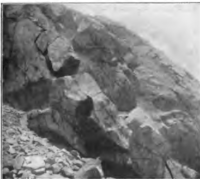
Fig. 273. — Paroi Sud-Sud-Est fissurée du dôme (15 mai 1907).
